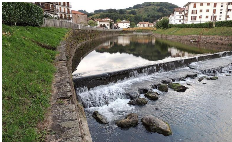
Estado previo a las obras (septiembre 2013). Desnivel de 1,5 m
