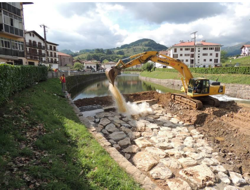
Ejecución de los trabajos
