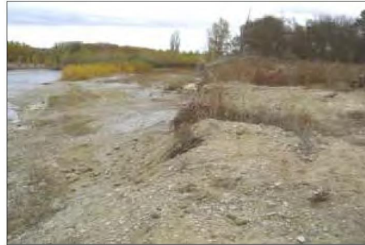
Estado inicial. Margen fuertemente erosionada.
