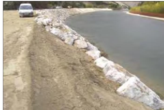
Defensa del talud de la margen con escollera.
