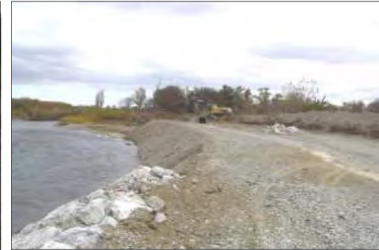
Recuperación del talud de la margen con aporte de tierras.
