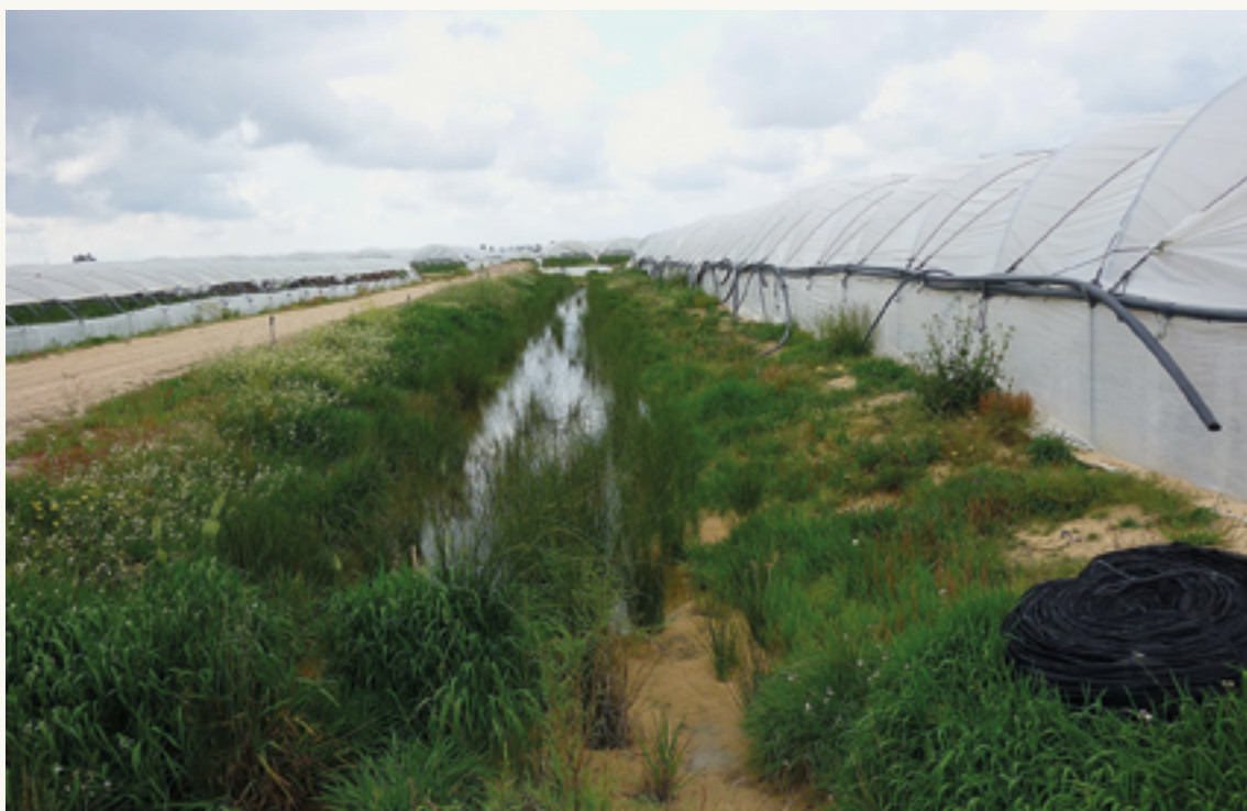
Canal de desagüe en buen estado.
