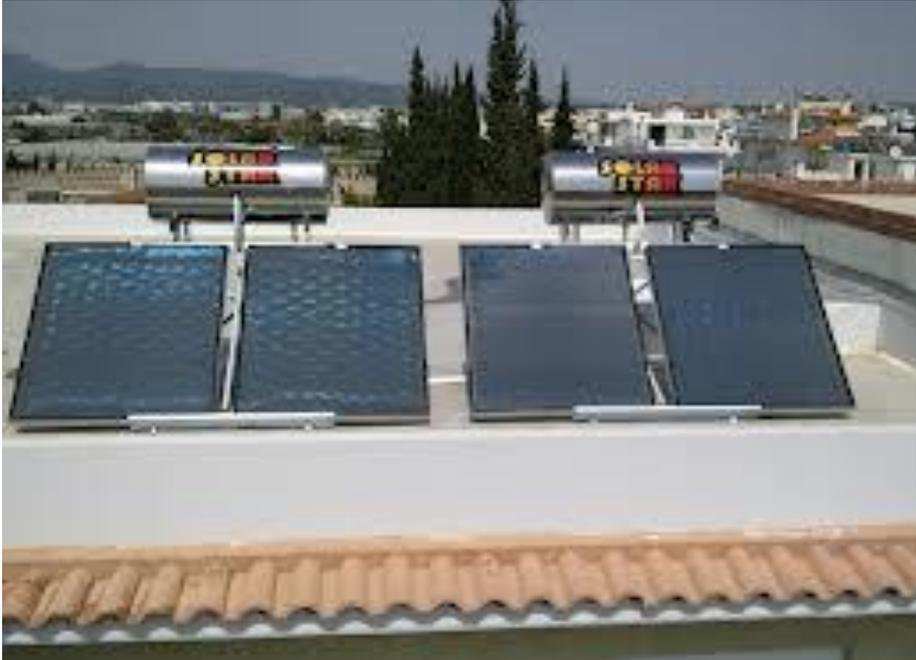
**Ilustración 24. Instalación de funcionamiento por termosifón.**
