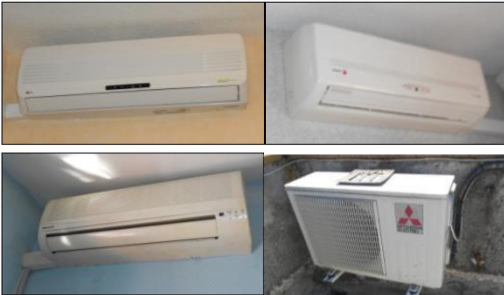
**Ilustración 6. Bombas de Calor**
