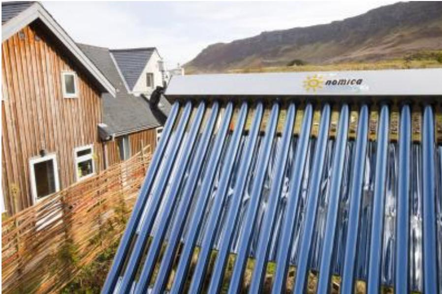
**Ilustración 28. Colector de tubos de vacío (fuente: WWF)**
