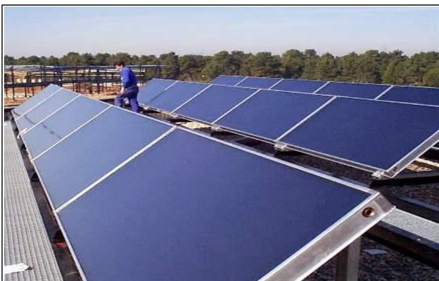
**Ilustración 27. Colectores de placa plana.**
