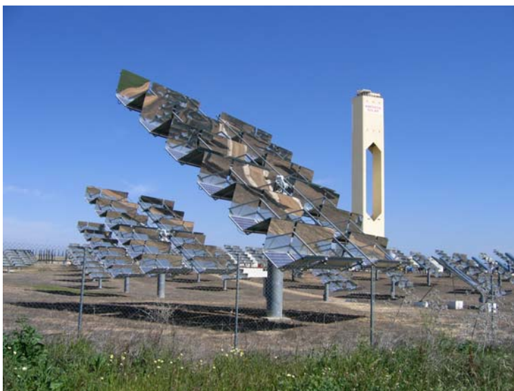
Planta Solar de Abengoa en Sanlúcar la Mayor
