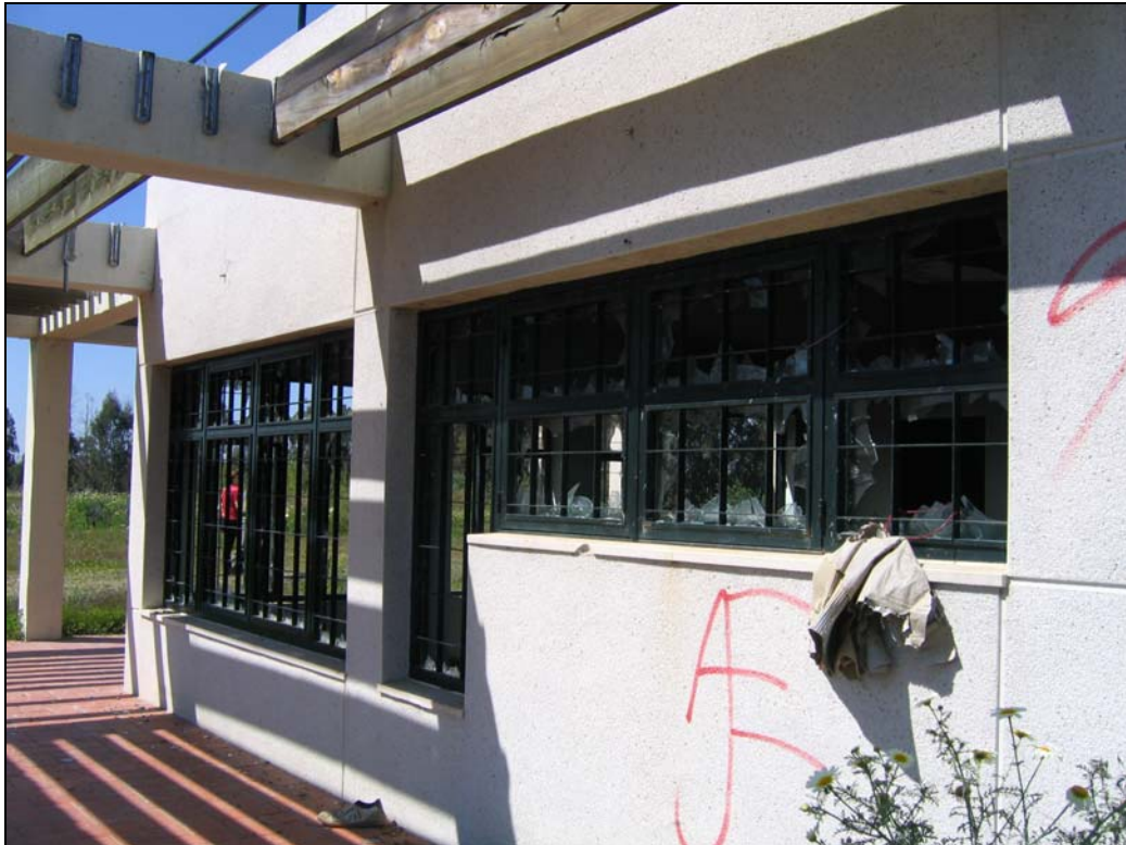
Ventanas rotas del equipamiento público de la Cuesta de las Doblas (Corredor Verde)
