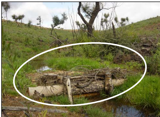
Correcta construcción de albarrada en un arroyo para evitar el aporte de sedimentos al mismo.
