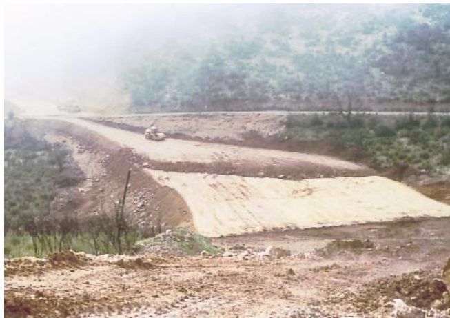
► Este tipo de taludes y terraplenes constituyen barreras infranqueables para el Lince ibérico. Carretera de Viso del Marqués a San Lorenzo de Calatrava.
