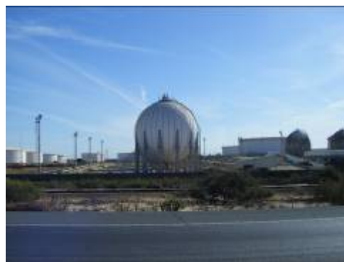
Instalaciones de Cepsa en Huelva
