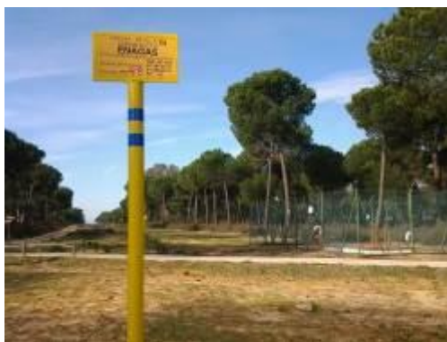
Gaseoducto Huelva-Sevilla que atraviesa los bosques del Espacio Natural del Doñana
