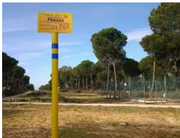
Gaseoducto Huelva-Sevilla en Hinojos
