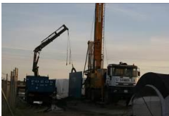
Construcción de un pozo denunciado por WWF
