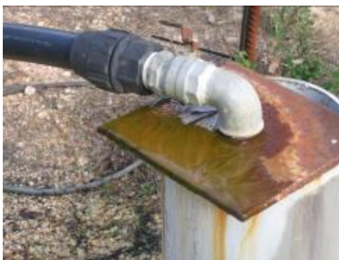
Toma en un pozo ilegal
