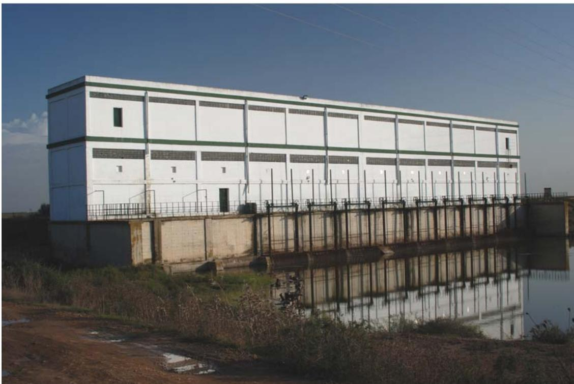
**Figura 20.** Estación de bombas en la vuelta de la Arena y el colector D-II-1. Este colector tendría que servir para llevar las aguas de la regeneración hídrica (desde Entremuros) como las aguas sobrantes de los regadíos (hacia Entremuros)
