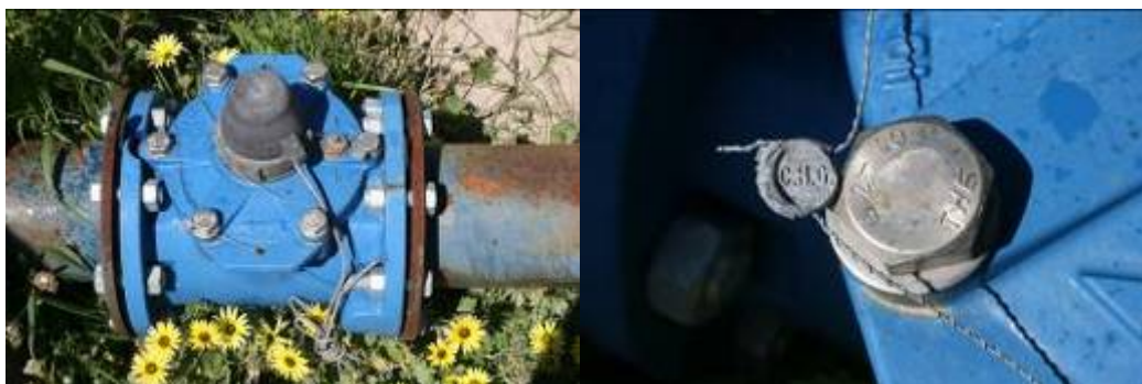
Caudalímetro controlado por la administración (Detalle: sello de la Confederación Hidrográfica del Guadalquivir)
