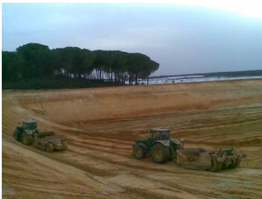
Construcción de una balsa de riego en la zona fresera, que WWF denunció por falta de permisos
