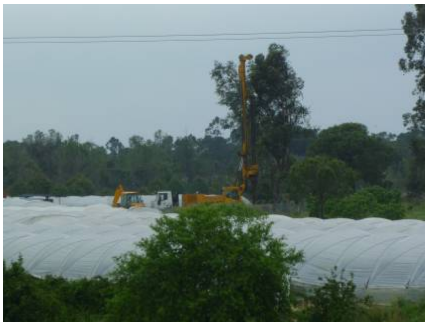
Construcción de un pozo ilegal en Bonares denunciado por WWF
