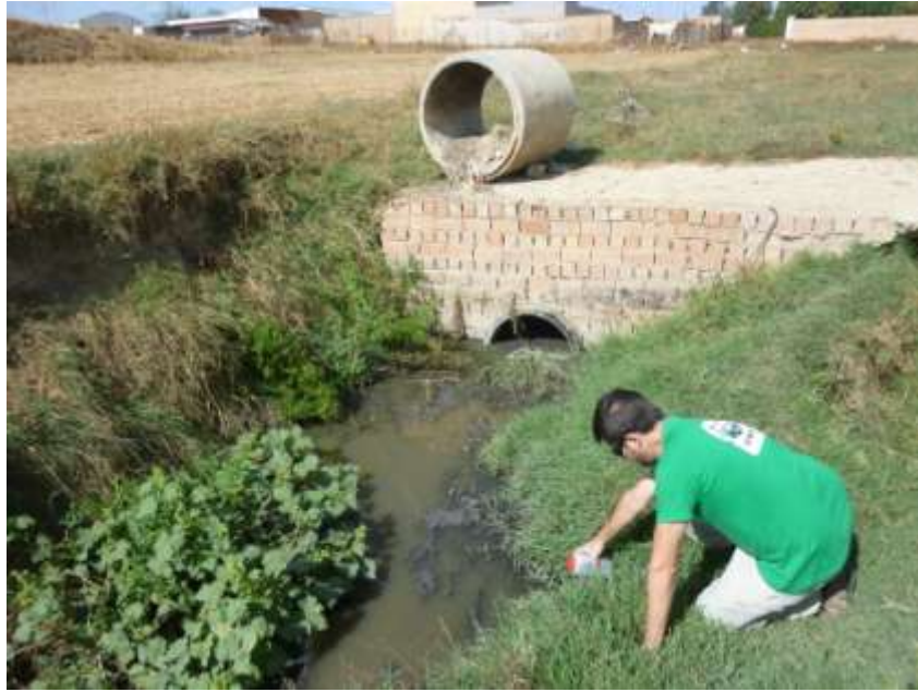
Detalle del vertido de aguas residuales en Almonte
