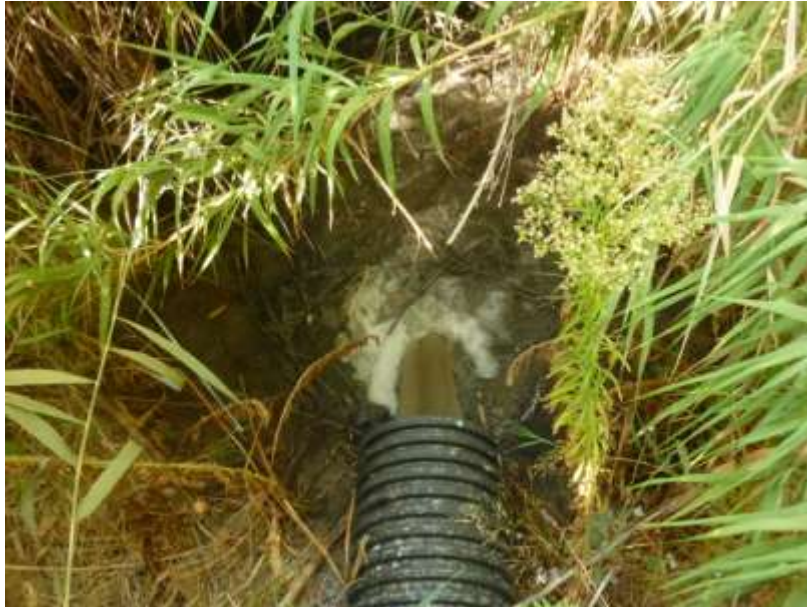
Salida de las aguas residuales al arroyo
