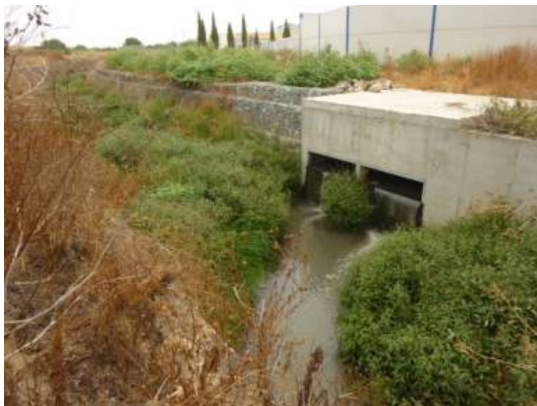
Aliviadero en Rociana del Condado
