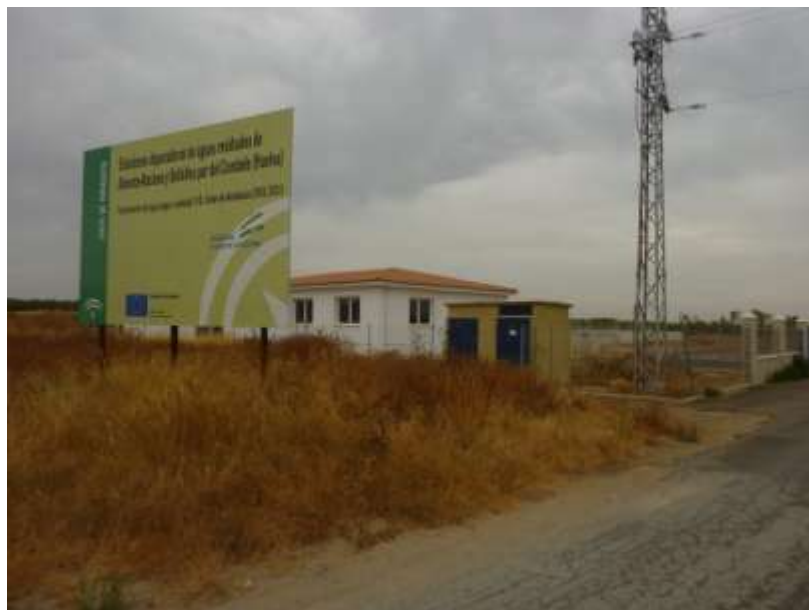
Instalaciones de la EDAR de Bollullos Par del Condado
