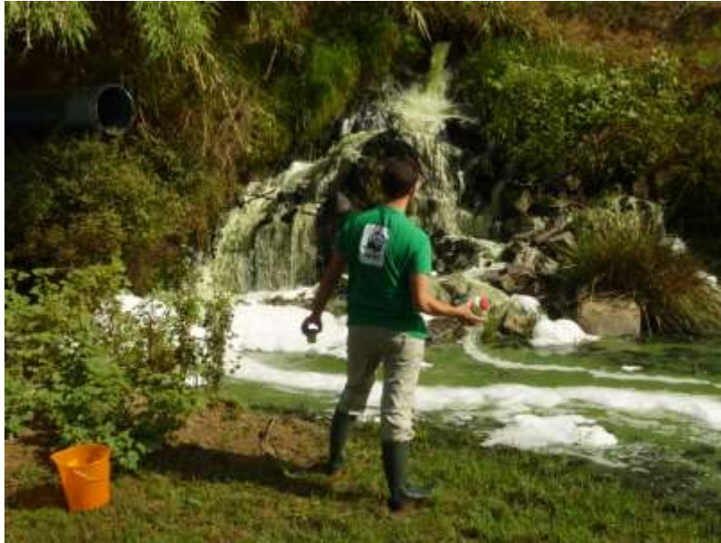
Salida de los vertidos de la EDAR de Almonte
