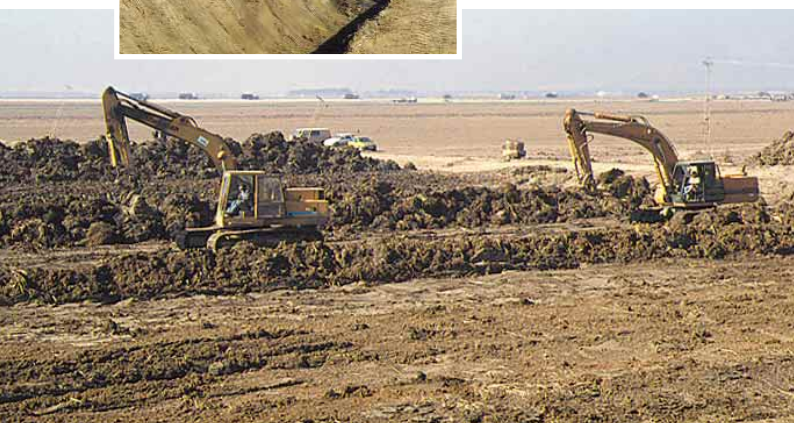
Diversas actividades de limpieza tras el vertido.
