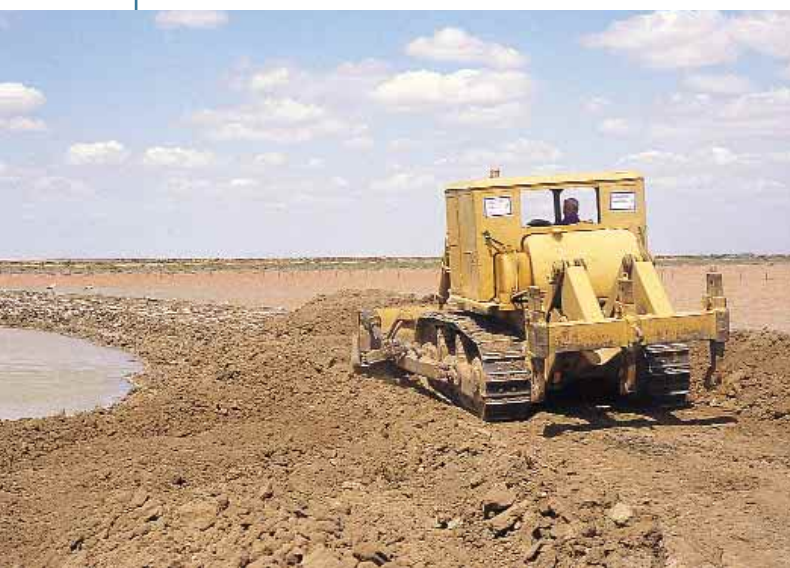
Construcción del segundo muro de contención en Entremuros.
