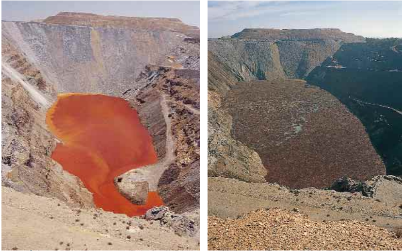
Antigua corta de Aznalcóllar, antes y después de acumular los lodos recogidos.
