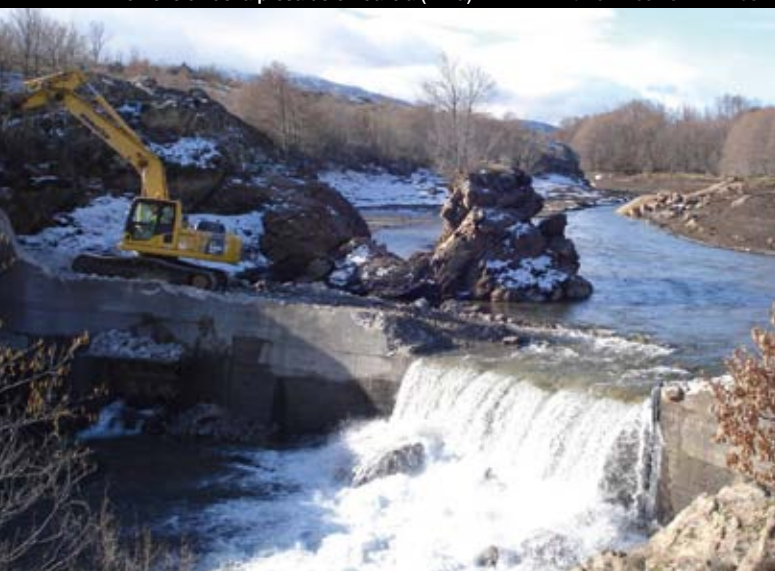
Demolición de la presa de Gil García (Ávila).
