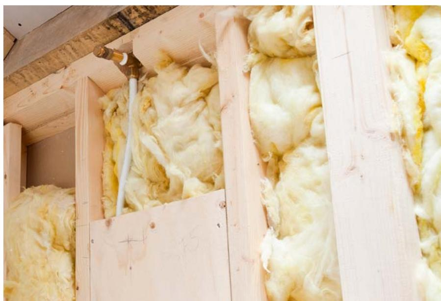
Aislamiento en paredes de entramado de baño.
