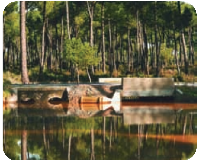
Arriba, paso de fauna en la carretera Almonte-Matalascañas (A-483); abajo, paso de fauna inundado.
