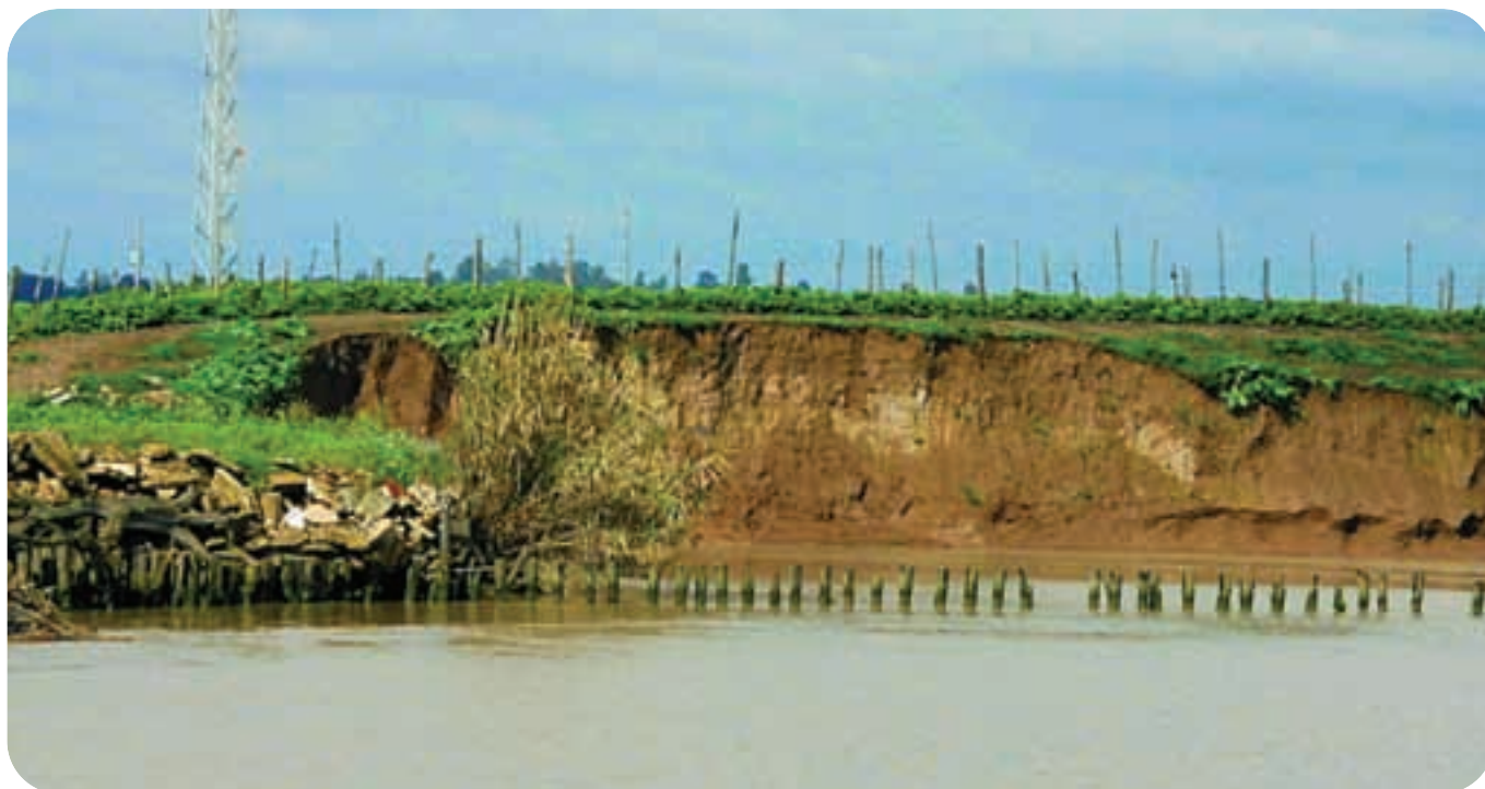
Erosión de márgenes en el río Guadalquivir.
