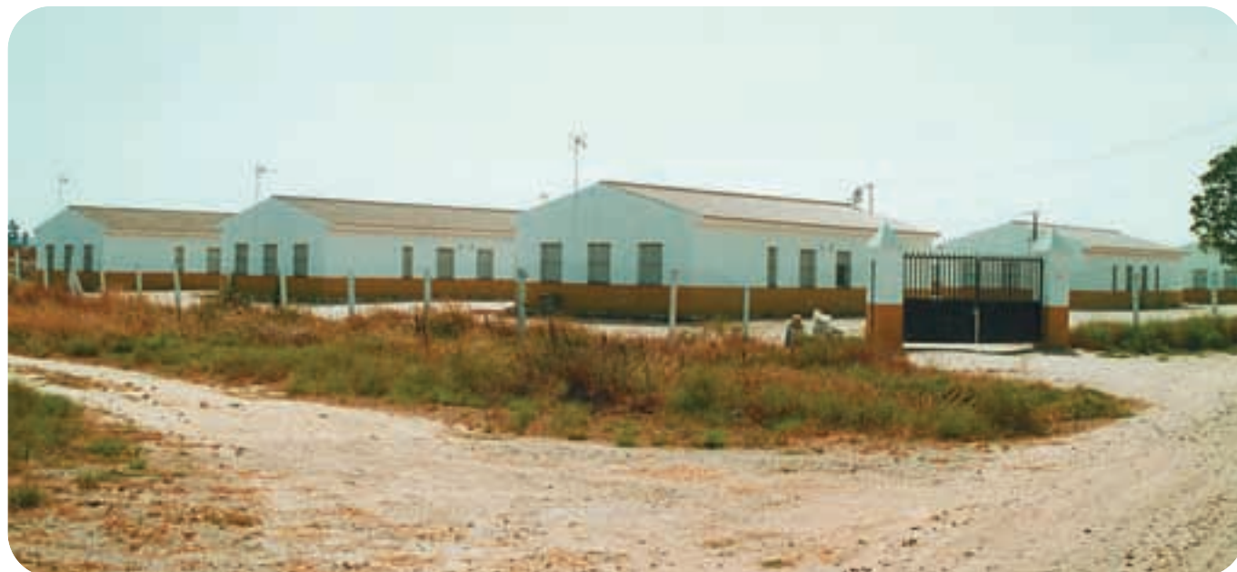
Viviendas para inmigrantes en Bonares.
